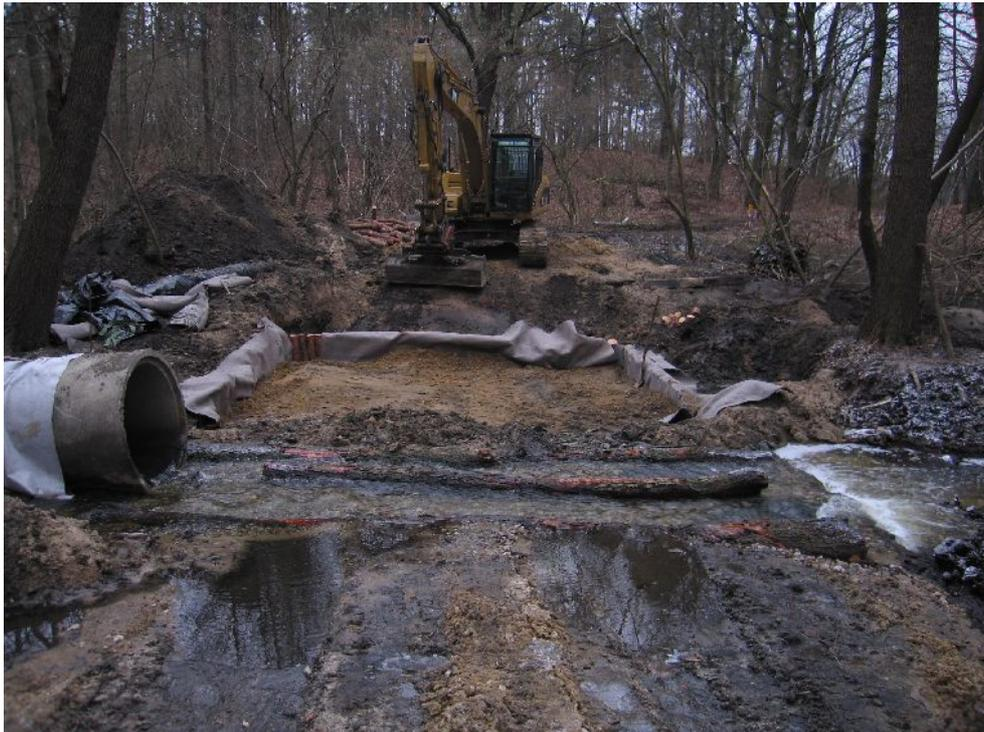
Abb. 2: Nach Rückbau des Durchlasses erfolgte der Aufbau der Furt auf der nördlichen Uferseite
