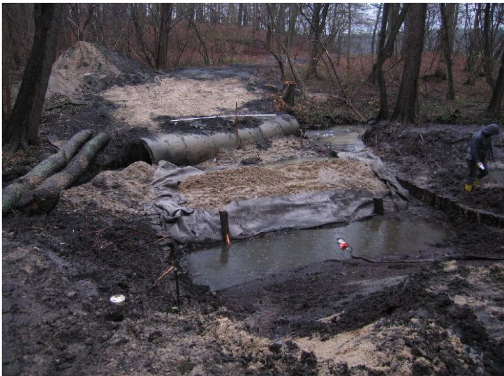
Abb. 1: Altbestand des Wegedurchlasses und im Vordergrund Auskoffnung und Aufbau der Furt.
