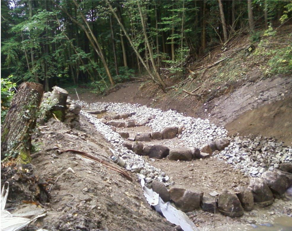
Abb. 4: Einbau der Querriegel im trocken gelegten Ragöser Fließ.
