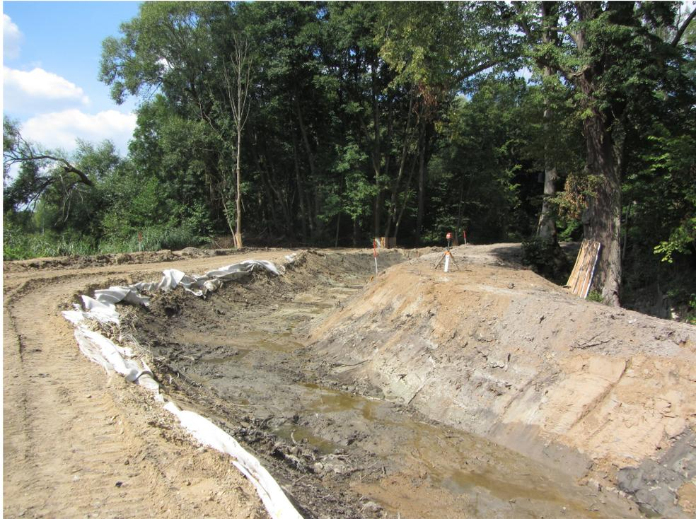
Abb. 3: Profilierter Verlauf der Fischaufstiegsanlage im ehemaligen Wehrumfluter.
